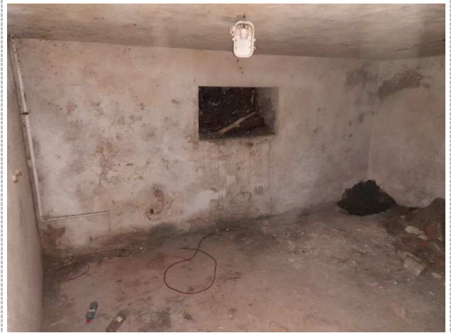
Zdjęcie nr 3. Ściana piwnicy wewnątrz budynku
